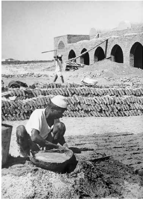
Abb. 5: Herstellung von Lehmziegeln auf der Baustelle von New Gourna, frühe 1950er Jahre.
