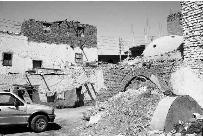
Abb. 10: Ruinöser baulicher Zustand von New Gurna, 2011. Foto durch den Autor.
